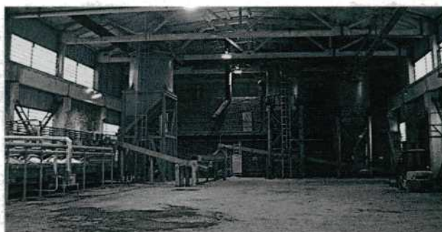
Рис. 4. Общий вид участка по производству искусственного гипсового камня
